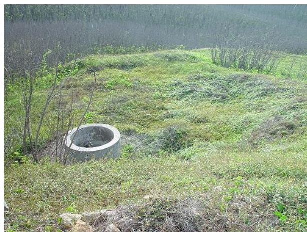
在斜坡上造井積水不易而形成空井
