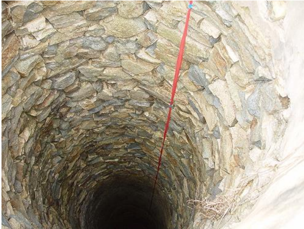
花嶼早期由岩塊堆砌而成圓柱形的水井，需要精巧的功力(灰綠色為安山岩，較黃色岩石為風化後的流紋岩，少部份為板岩)
