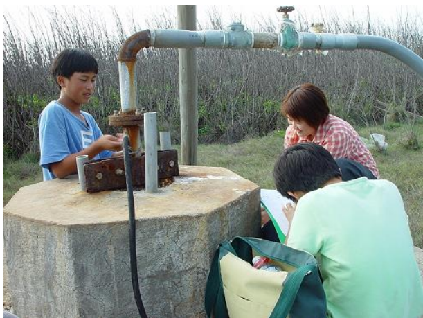
花嶼目前的飲用水水源井井口大部份封住 僅留出水口因此較不易受污染
