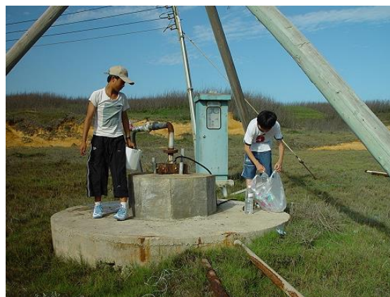
煙墩山下的飲用水井，遠離社區，井口封閉 不易受到污染，井深約 70 公尺，海拔高約 30 公尺。
