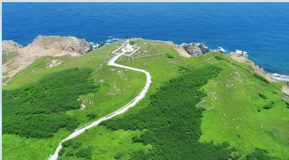
從空中俯瞰花嶼燈塔。
